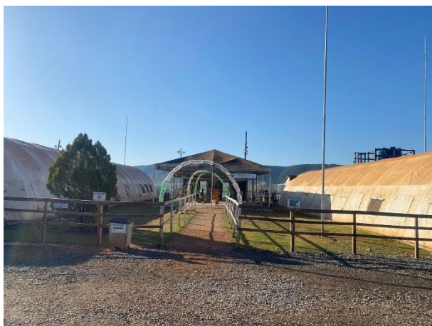
Foto 1: Área de vivência do canteiro industrial (10/06/2022)
