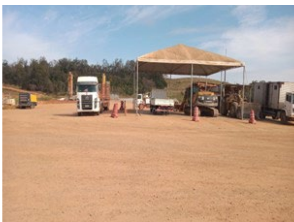
Foto 3: Vista Oficina Mecânica (24/08/2022)
