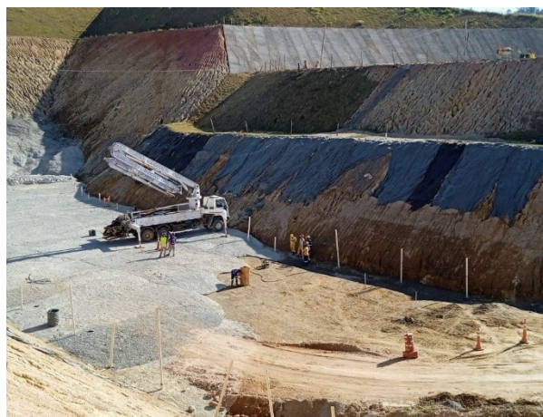
Foto 11: Vista panorâmica da Ogiva (27/07/2022)
