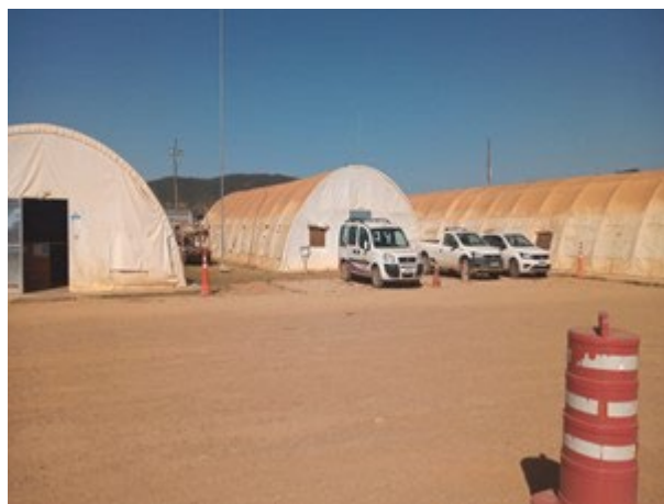
Foto 2: Vista de áreas de apoio do canteiro industrial (07/07/2022)
