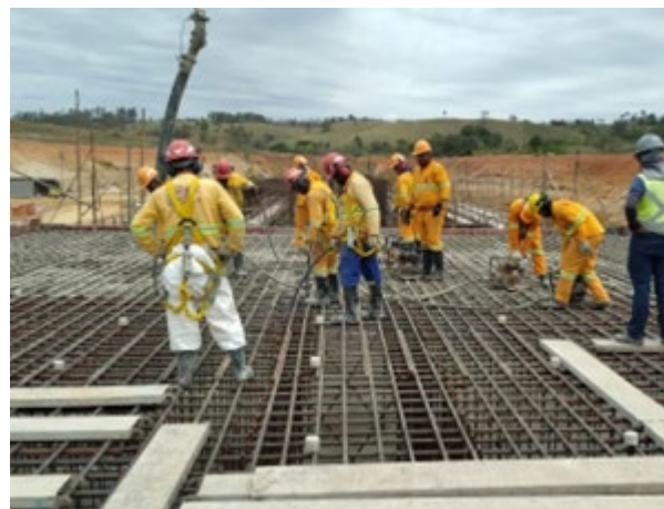
Foto 13: Vista panorâmica da galeria de desvio (27/09/2022)
