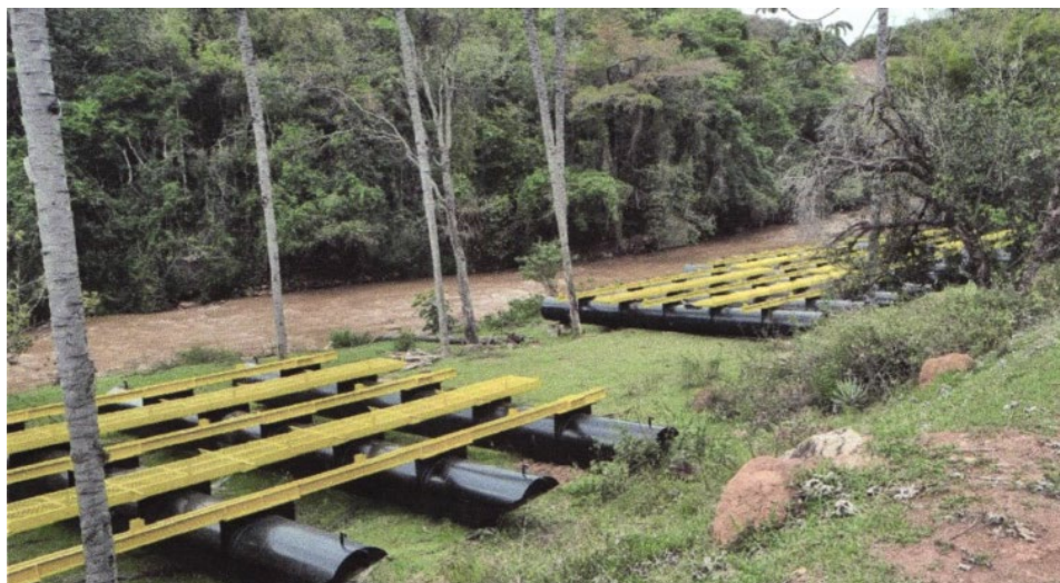
Foto 9- Montagem de equipamentos e sistemas flutuantes. 09/2022
