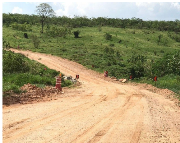
Foto 17: Acesso sob o Ribeirão Pantaleão – (30/09/2022)
