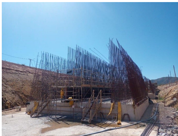
Foto 12: Vista panorâmica da galeria de desvio (24/08/2022)
