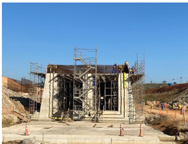
Foto 10: Vista panorâmica da galeria de desvio (26/06/2022)
