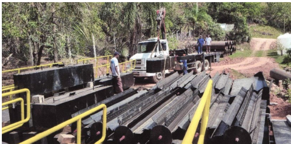
Foto 7-Montagem de equipamentos e sistemas- rodas de dragagem. 08/2022
