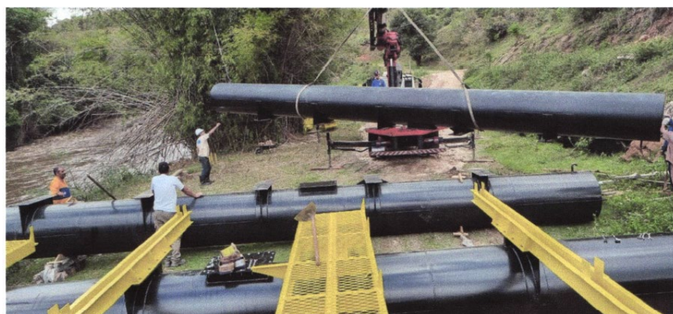
Foto 8- Montagem de equipamento e sistemas. 09/2022
