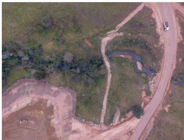
Foto 16: Acesso sob o Ribeirão Pantaleão - (16/07/2021)
